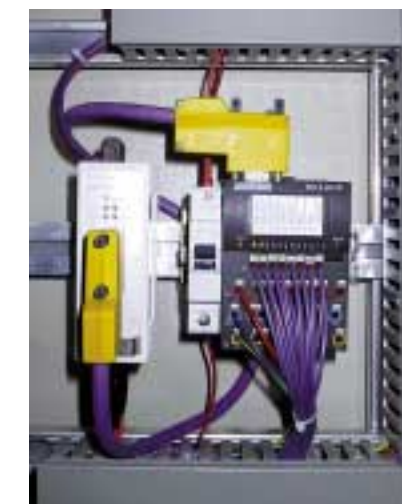
SAIA®PCD6 mit Erweiterungs rack als Kopfstation (Bild rechts) und dezentraler Schaltschrank unter einer SOS-Nische mit LWL-Konverter zur RIO Typ PCDO (Bild oben).
