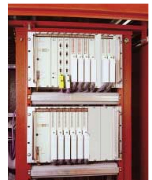
SAIA®PCD6 mit Erweiterungs rack als Kopfstation (Bild rechts) und dezentraler Schaltschrank unter einer SOS-Nische mit LWL-Konverter zur RIO Typ PCDO (Bild oben).
