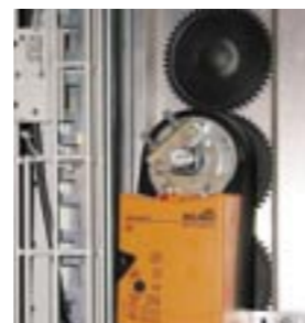
Klappenantrieb von Belimo® angeschlossen an den MP-Bus über Woertz-Anschlussklemme
