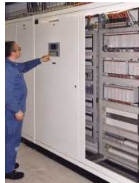
Die PCD4 im Dachboden des Hauptgebäudes steuert und regelt die Lüftungs- und Klimaanlage in den Hörsälen.
