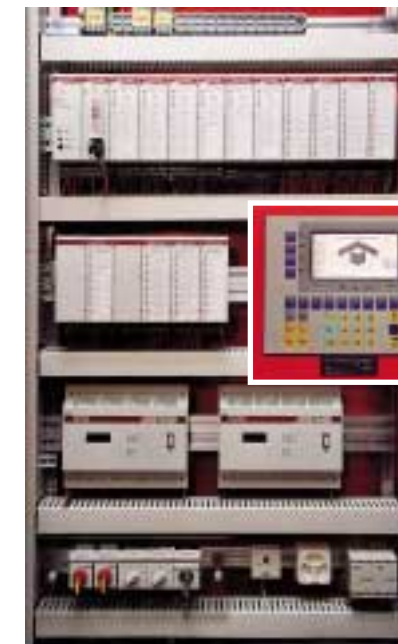
Die SAIA®PCD4 im Gebäude SOC steuert die Zeitprogramme für die Türschliessungen.
