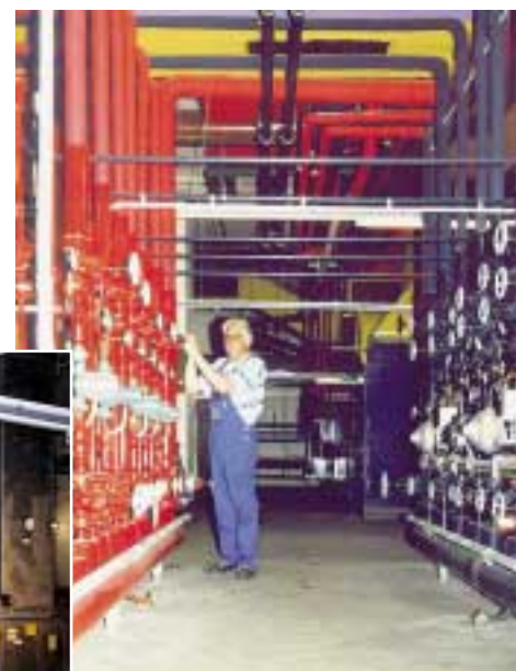
Klimazentrale 1 mit Heizungsverteiler.
