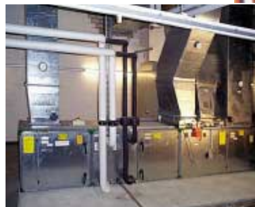
Klimazentrale 1 mit Heizungsverteiler.
