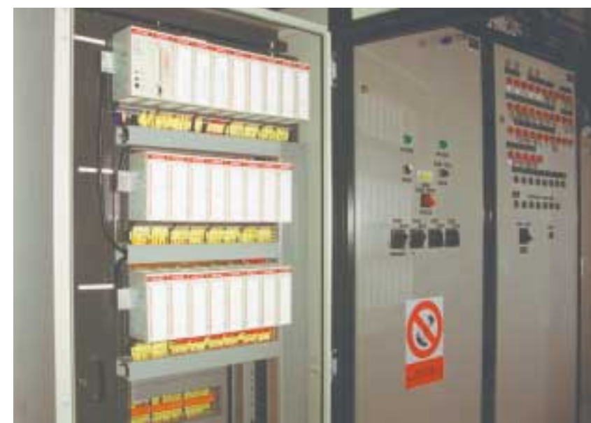
Eine der 14 PCD4-Unterstationen enthaltend 3 Analog- und 21 Digital-Module mit total ca. 400 E/A.
